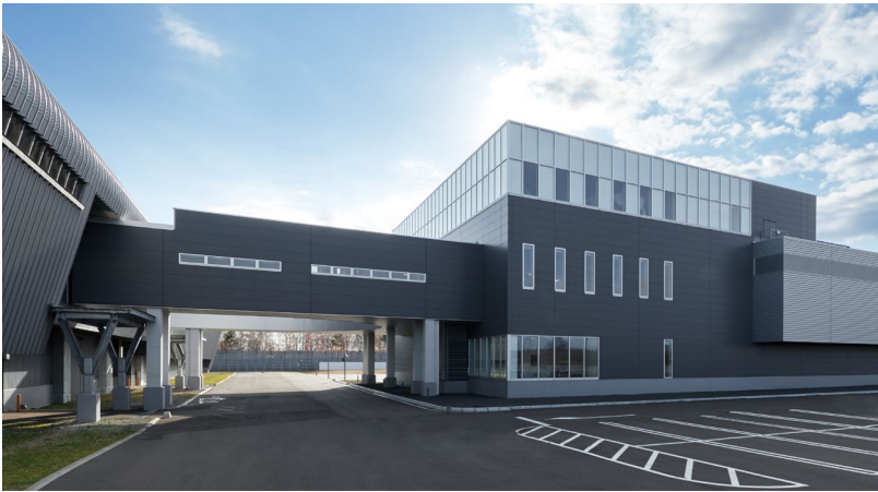
石狩データセンター 3号棟
