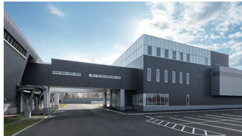
石狩データセンター 3号棟
