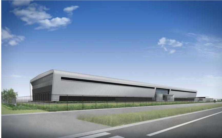
クラウドコンピューティングに最適化した国内最大級の郊外型データセンター。東京ドームの約1.1倍という広大な敷地を活かしたスケールメリットと、北海道の低温外気を活用した外気冷房システム、画期的な電力効率をほこるHVDC給電システムにより、世界最高レベルのエネルギー効率と低コストを実現。
