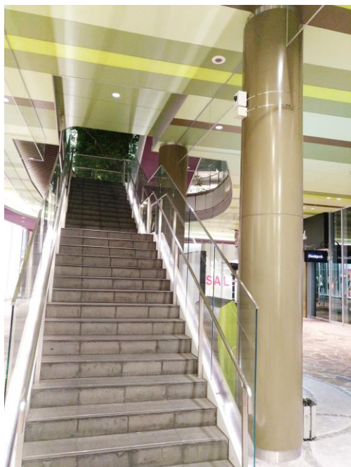
写真1：人流センサー設置箇所（現場写真）
