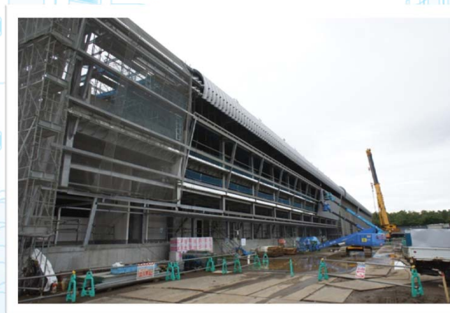
▲ 施工中の石狩データセンター (2011年7月15日撮影)
