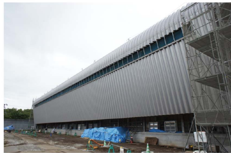
▲ 施工中の石狩データセンター （2011年7月15日撮影）
