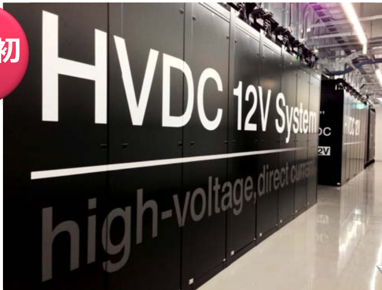
▲ 石狩データセンター商用環境の HVDC DC12Vシステムのサーバラック
