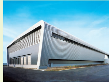
石狩データセンター1号棟外観(左)とサーバールーム(右)
