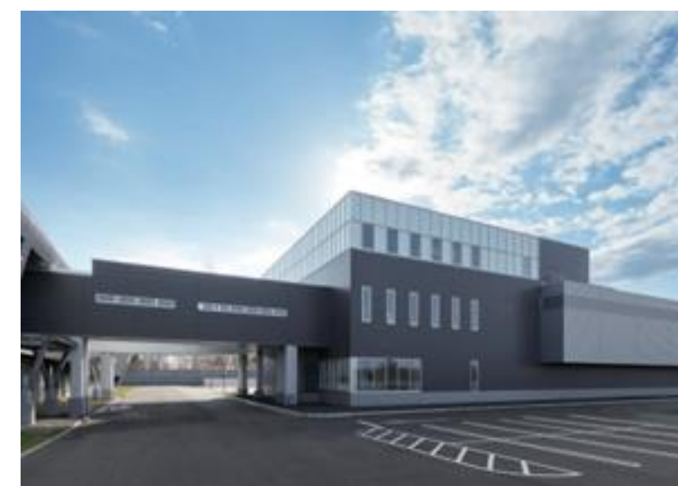
▲石狩データセンター
