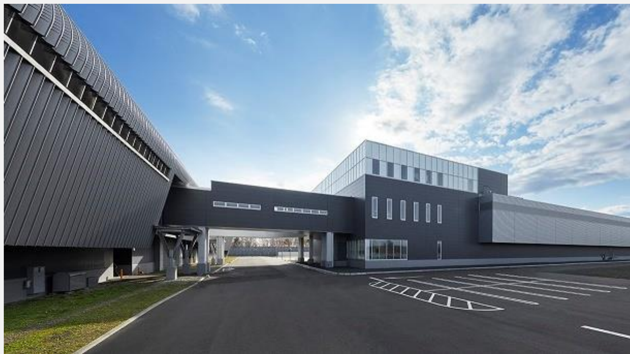
▲石狩データセンター外観（正面：3号棟、左：1・2号棟）
