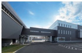
石狩データセンター 3号棟
