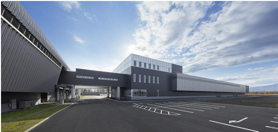
石狩データセンター外観（正面3号棟、左：1・2号棟）
