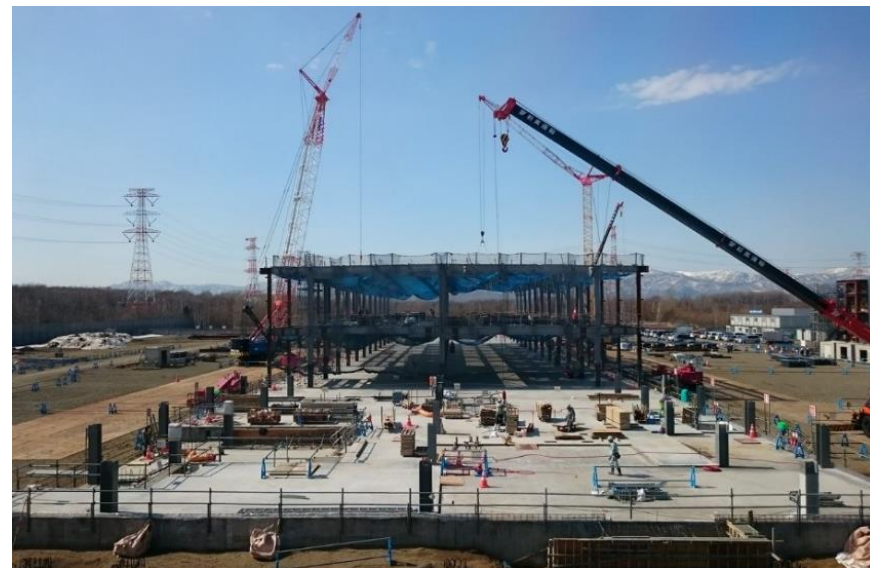
石狩データセンター3号棟の建設風景
